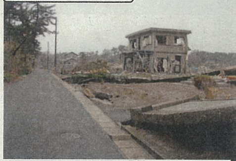
0.0k右岸付近(被災状況)
