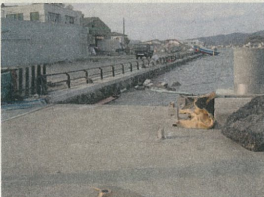
・旧北上川河口部の緊急高潮堤が流失・陥没。 ・地盤も大きく沈下
