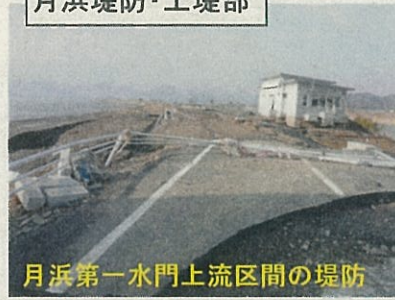
月浜堤防・土堤部
