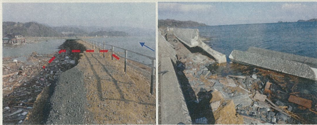
土堤部(終点側より2.6k付近・左岸)
