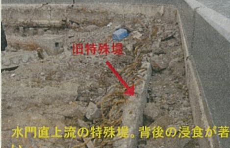
パラペットの損傷は見られない 天端は舗装版が剥がされた状 右岸特殊堤上流より河口を望
