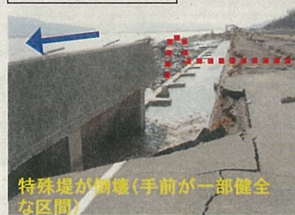
月浜堤防・土堤部
