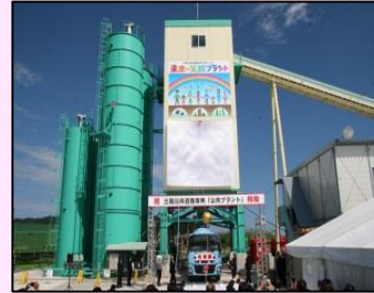
宮古地区の公共プラント
