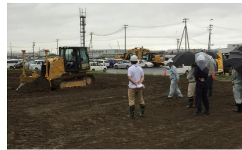
▲ICT活用工事技術講習会:実習
