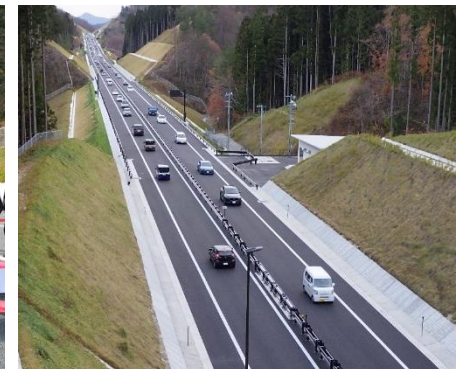
▲H29.11.19山田宮古道路 開通後の状況
