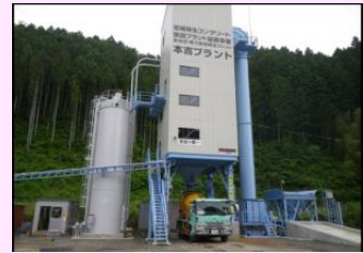
気仙沼地区(本吉)の仮設プラント
