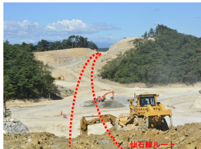
仙石線部の工事状況
