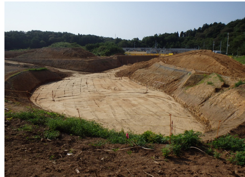
離半島部 出島地区の造成に向けた地盤改良完了
