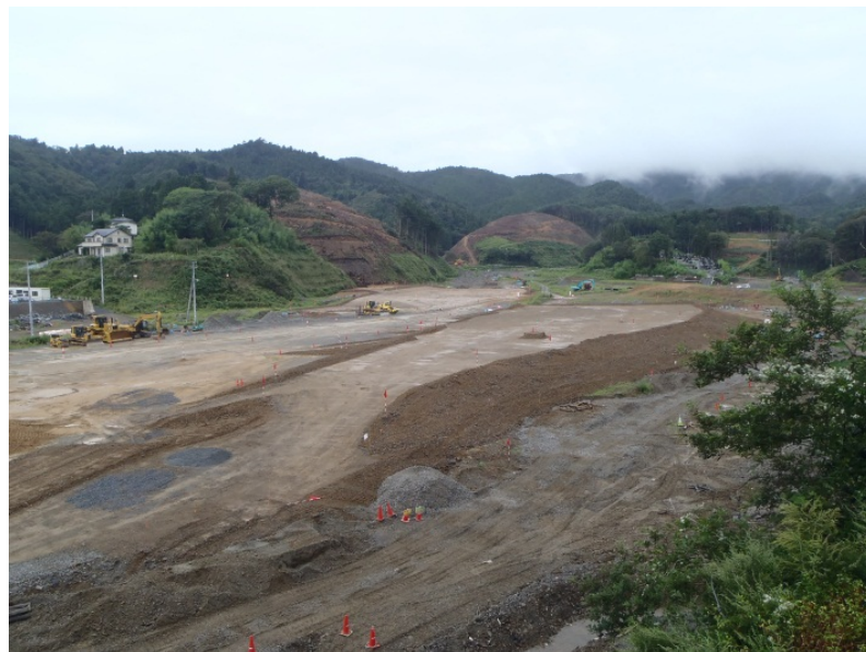
中心市街地 駅周辺の本格造成(盛土)工事開始状況
