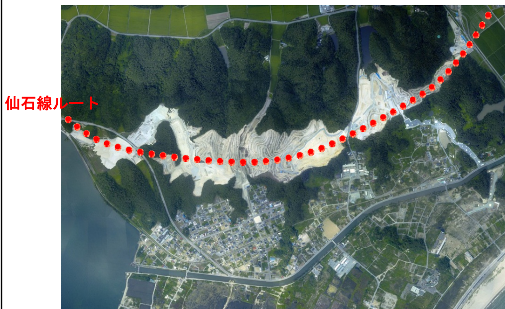
造成工事の着手状況 (H25.8.18)
