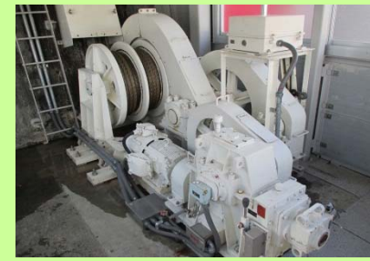
□釜房ダム クレストゲートとワイヤーロープウインチ式開閉装置
