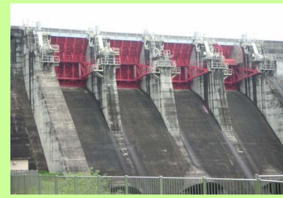
□釜房ダム クレストゲートとワイヤーロープウインチ式開閉装置
