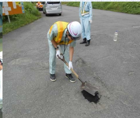
【道路損傷復旧】
