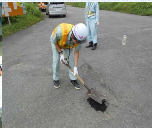
【道路損傷復旧】
