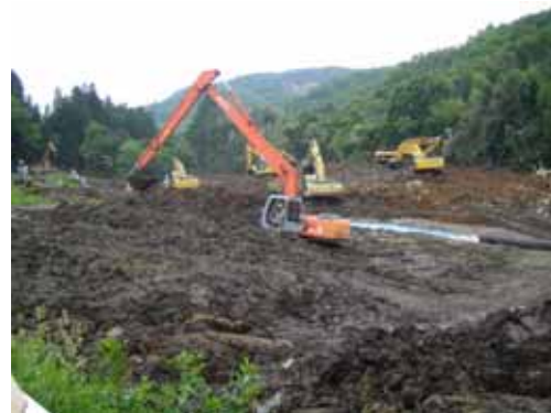
一関市・市野々原地区 (排水対策作業状況)
