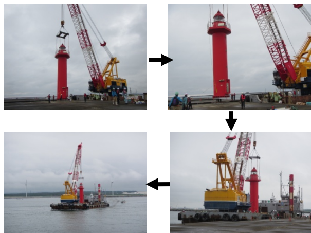
(写真-3) 起重機船による運搬状況
