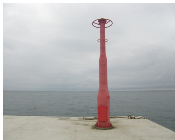
(写真-6) 標識灯撤去前
