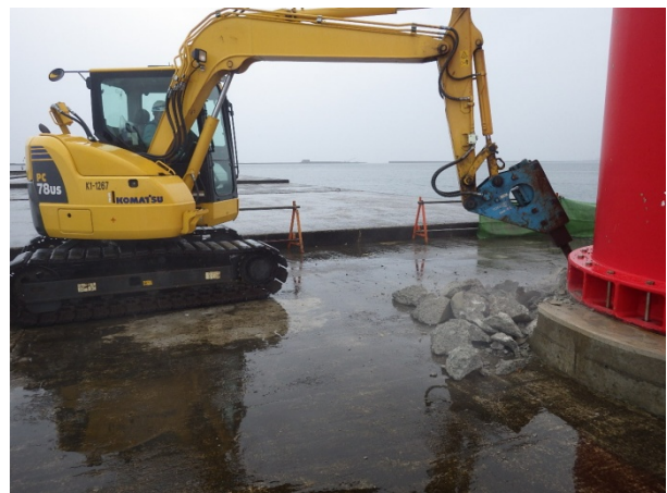
(写真-2) 灯台基礎取壊
