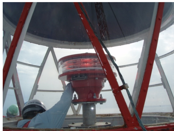
（写真-5）点灯確認
