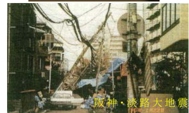
▲地震による電柱の倒壊で、電力・電話等ライフラインが寸断(イメージ)
