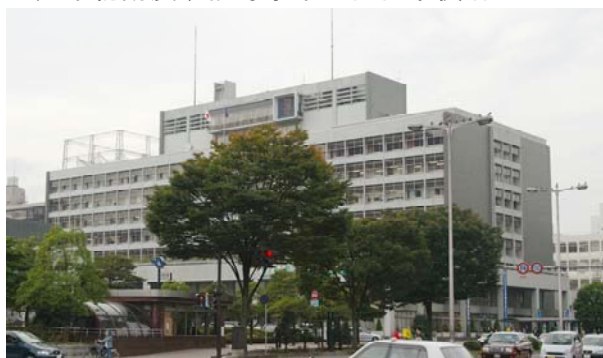
【耐震補強工事を実施する仙台市役所本庁舎】
