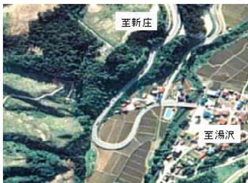
◀危険な現道のヘアピンカーブ (金山町飛ノ森付近)
