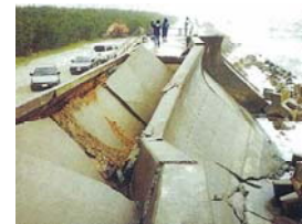
▲急激に進む海岸侵食によって海岸保全施設が被災(H3)
