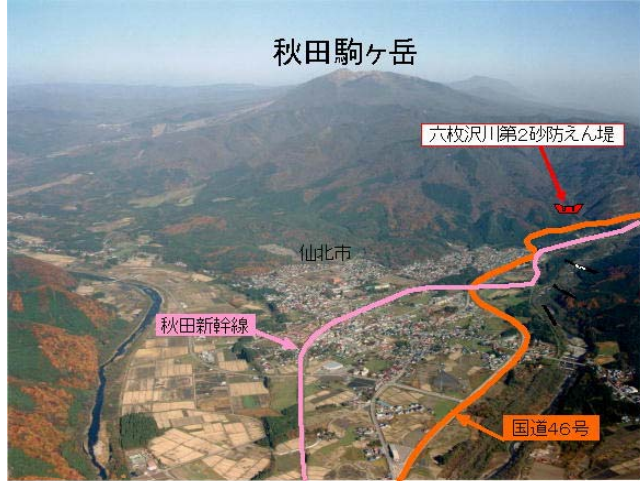
▲えん堤の整備により市街地や重要交通網の土砂災害を軽減
