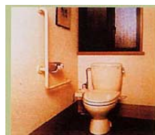
▲手摺り付きトイレ
