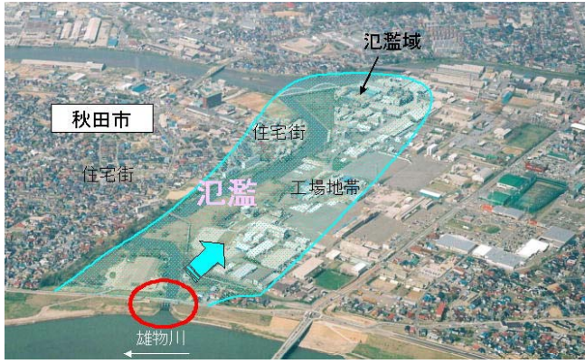
▲背後に住宅街や工場地帯のある新屋水門が転倒したら甚大な被害の発生が予想されます
