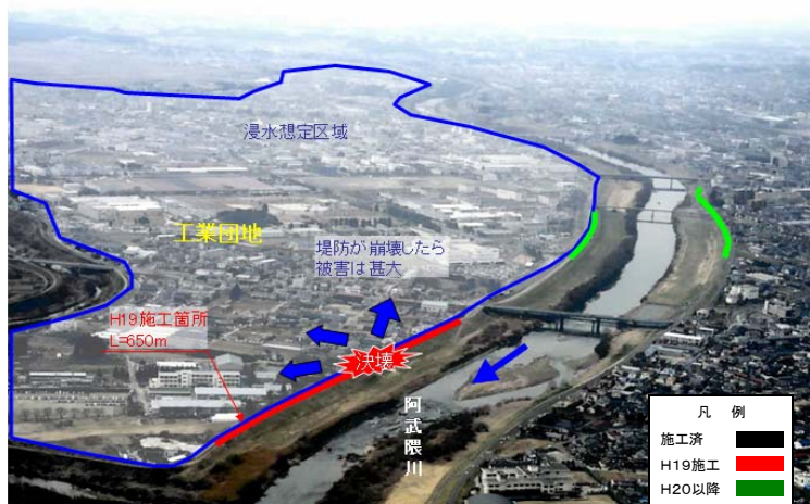
▲堤防の質的整備によって、市街地や工業団地を洪水から守ります
