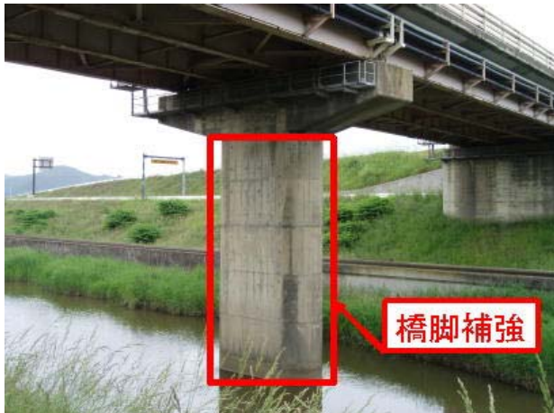
▲大地震に耐え、緊急輸送道路が確保できるよう耐震補強を実施
