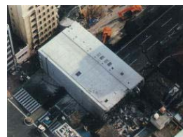
地震によりビルが倒壊し、道路が完全に閉鎖(神戸市の例)
