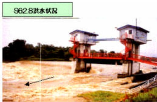
洪水の流れを阻害している旧大久保堰
