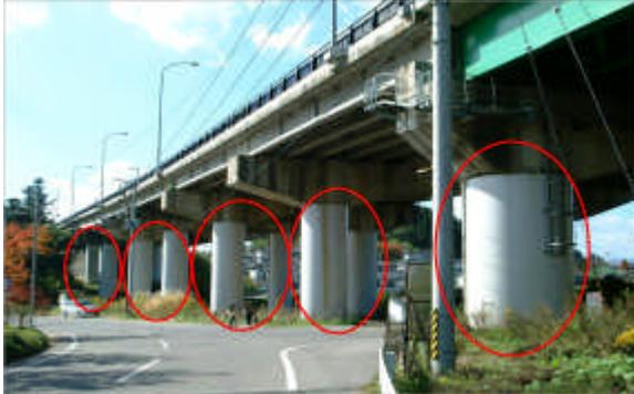
橋台・橋脚に被害が生じないように補強を施します。さらに、橋桁が橋台・橋脚から外れることのないよう落橋防止対策も施します。
