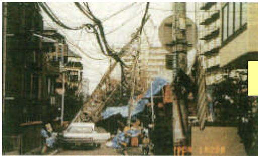
地震による電柱の倒壊で、電気・電話等ライフラインが寸断
