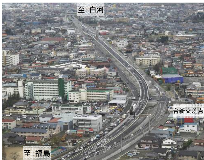
▲針生地区立体化全景
